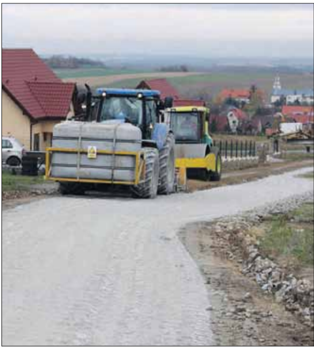
W ramach prac wykonano m.in. podbudowę drogi
