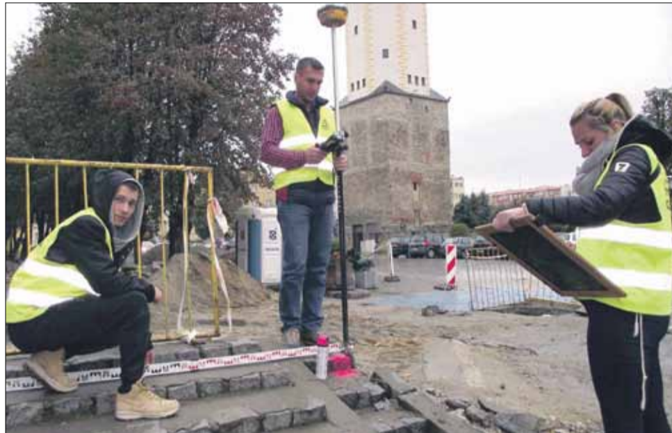
Firma realizuje m.in obsługę geodezyjną prac związanych z przebudową południowej pierzei strzelińskiego rynku
