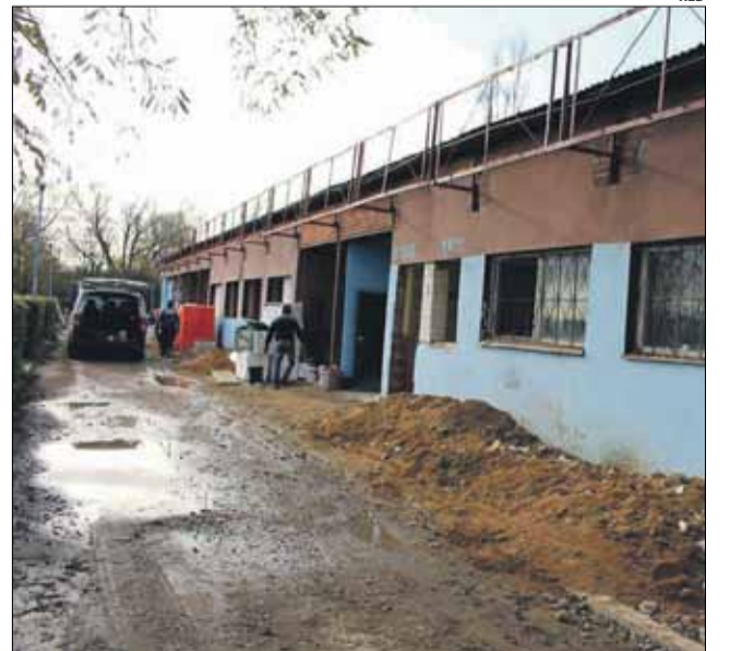
Prace prowadzi firma Ciepły Dom z Karnkowa
