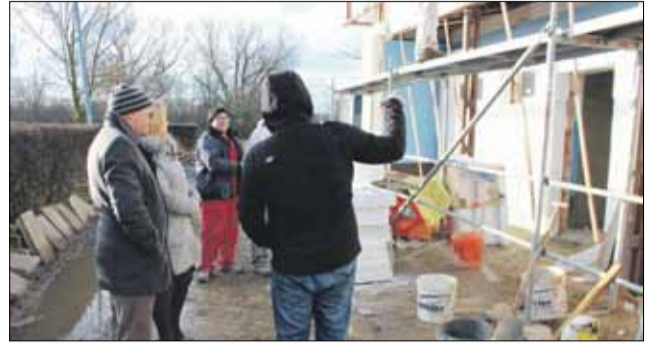
Burmistrz Dorota Pawnuł i pracownicy wydziału zajmującego się inwestycjami są częstymi gośćmi na placu budowy
