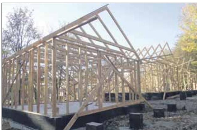
Szkielety domków parterowych stoją już na terenie Ośrodka Wypoczynkowego „Nad Stawami” w Białym Kościele
