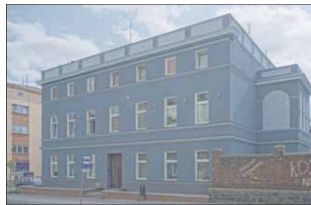
Elewacja budynku już nie straszy widokiem, a prezentuje się imponująco
