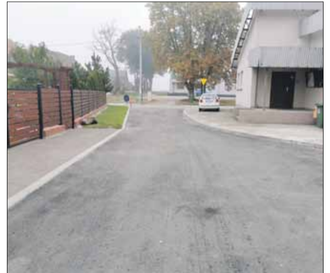
Droga w Biedrzychowie została wyremontowana
