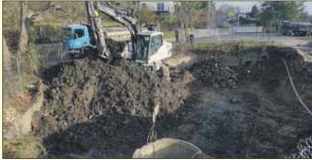
Na ulicy Akacyjnej w Gęsińcu trwają prace
