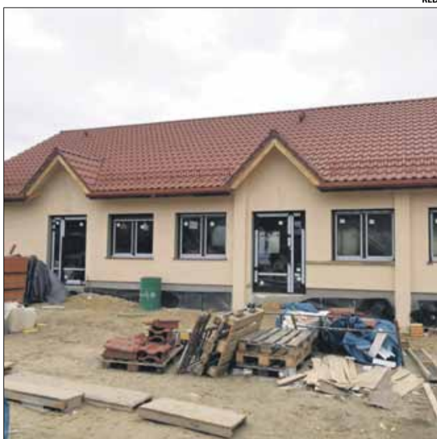
Budowa świetlicy w Gościęcicach zakończy się w tym roku
