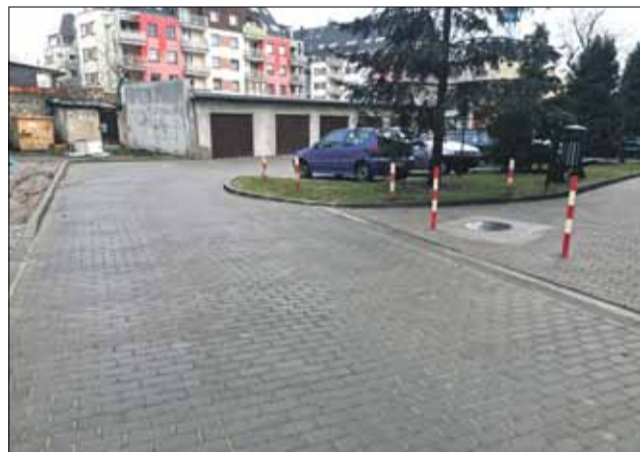
Droga osiedlowa przy ul. Staszica doczekała się przebudowy
