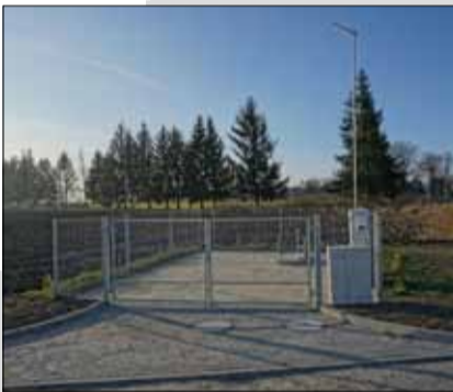
Przepompownia w Karszowie
