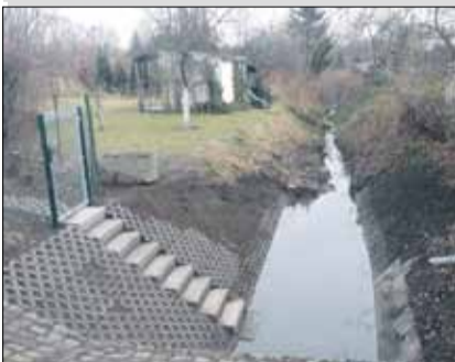
Wyremontowany rów melioracyjny
