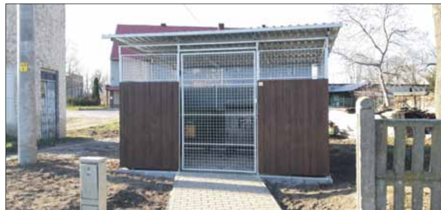
Nowa wiata na kontenery przy Wspólnocie Mieszkaniowej Mikosów 34A
