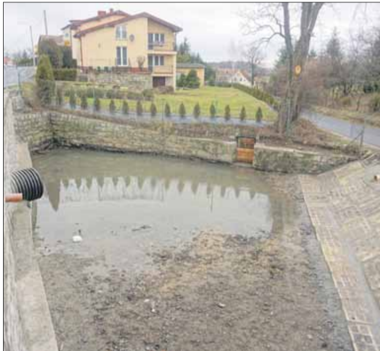
Odbudowany przepust drogowy w Gęsińcu
