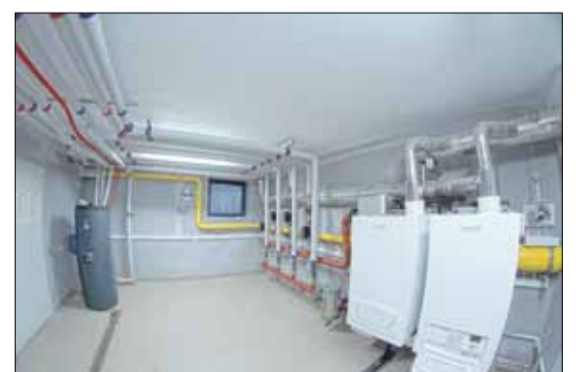
RED Nowa kotłownia SOK
