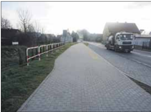
Mieszkańcy Strzegowa korzystają już z nowego chodnika
