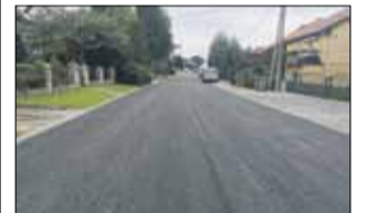
Ul. Zawadzkiego w StrzeLinie po remoncie
