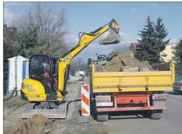
Prace są prowadzone m.in. na wysokości budynku socjalnego
