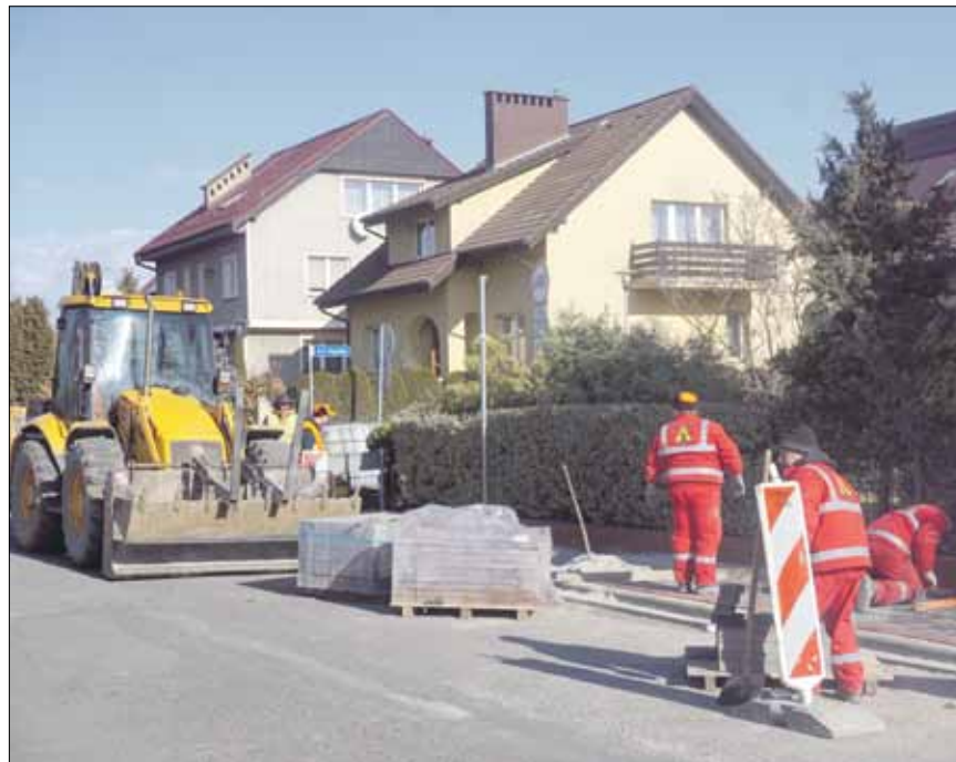
Obecnie wykonywany jest nowy chodnik
