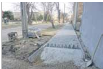
Na ul. Brzegowej wykonano już znaczną część chodnika
