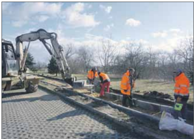
Prace trwają m.in. na wysokości przyszłego parkingu
