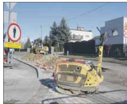
Prace na ul. Konopnickiej przebiegają zgodnie z harmonogramem
