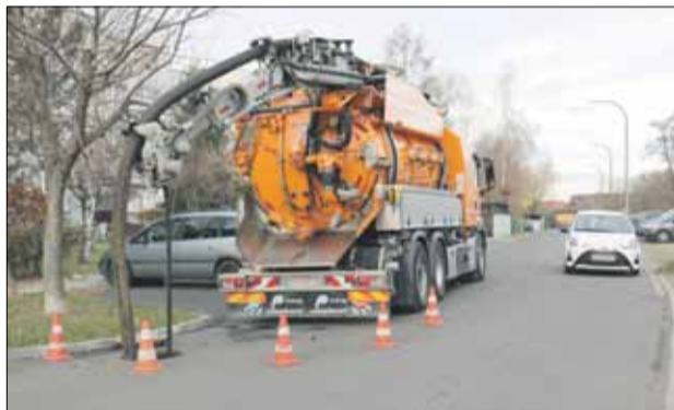
Renowację kanałów prowadzono m.in. na ulicy Grota Roweckiego w Strzelinie
