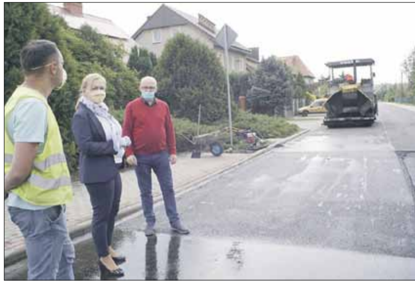
RED Przedstawiciele magistratu sprawdzili m.in. postępy prac przy budowie wyniesionego przejścia dla pieszych
