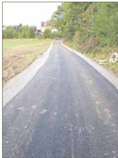
Inwestycję w Gęsińcu realizowało Przedsiębiorstwo Robót Drogowo - Mostowych z Brzegu
