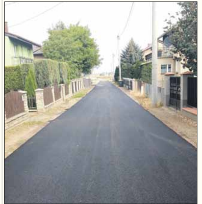
Ulica Kryształowa w Szczawinie została wyremontowana
