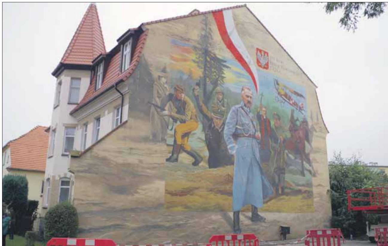
Dzieło znajduje się na ścianie budynku przy ul. Rybnej 10 w Strzelinie
