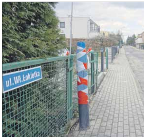
Słupy oświetleniowe zdemontowano m.in. na ul. Władysława Łokietka
