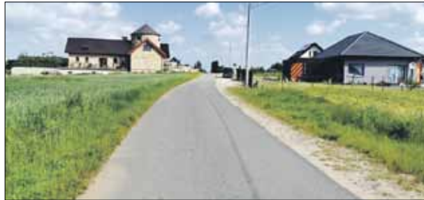
RED Przy ul. Sosnowej w Gęsińcu zaplanowano zamontowanie ośmiu energooszczędnych opraw oświetleniowych
