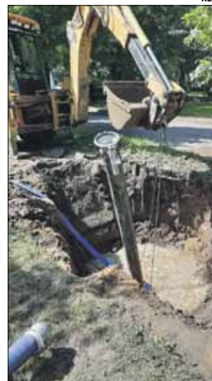
Pracownicy ZWIK w Strzelinie usuwali awarię m.in. w ulicy Staszica
