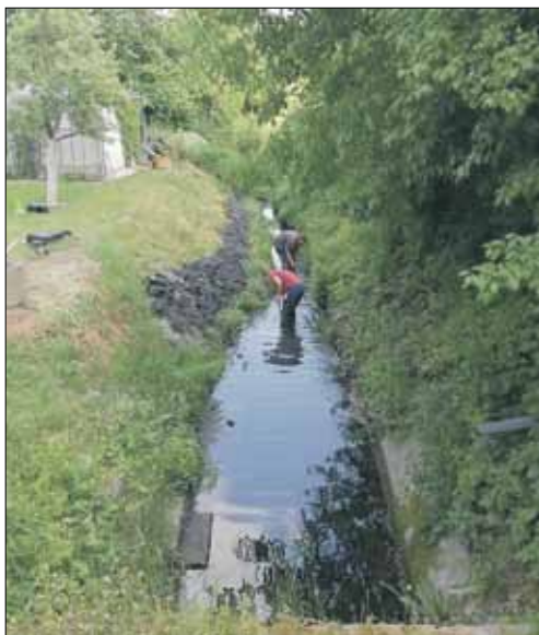
W ostatnim czasie pracownicy CUKiT wycyzlili m.in. rów odwadniający przy ul. Okulickiego w Strzelinie
