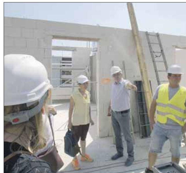
Gości oprowadzili po budowie prezes spółki Zdzisław Rataj oraz kierownik budowy Krzysztof Okulicz
