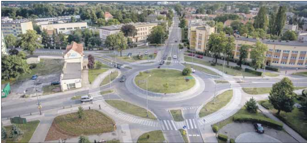
Przebudowa strzelińskiego ronda coraz bliższa
