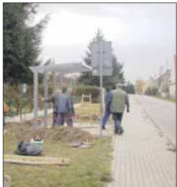
Pracownicy Centrum Usług Komunalnych i Technicznych w Strzelinie zamontowali wiatę przystankową w Karszowie
