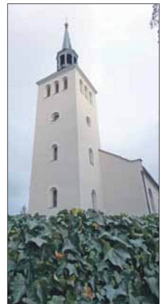
Wieża nowoleskiej świątyni z nową elewacją
