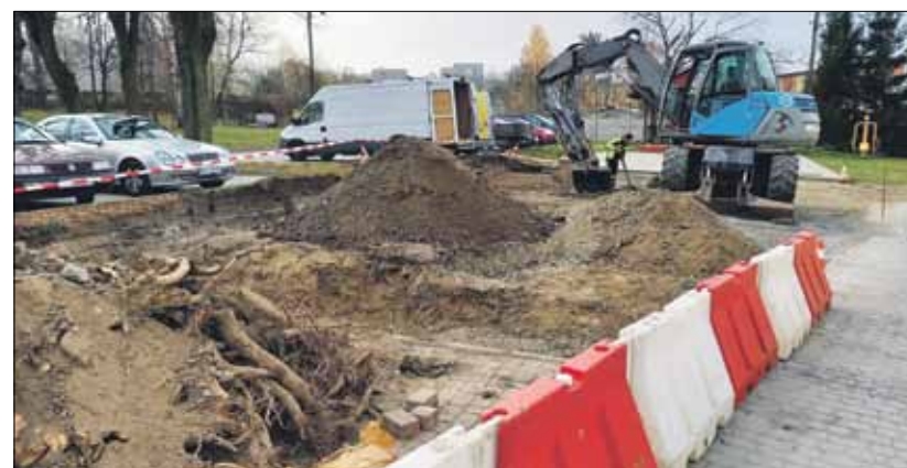
Przy świetlicy w Gęsińcu powstanie dodatkowych siedem miejsc postojowych
