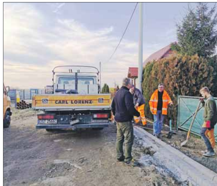
Inwestycję realizuje firma Usługi Transportowe i Roboty Ziemne Tomasza Bartkowskiego z Przeworna
