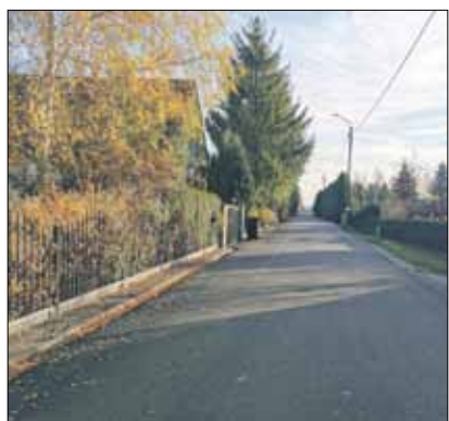
Po ułożeniu kanalizacji sanitarnej postanowiono wyremontować ul. Klonową w Pławnej
