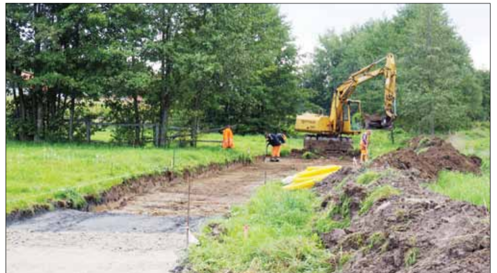
Na ulicy Spacerowej w Białym Kościele trwają intensywne prace
