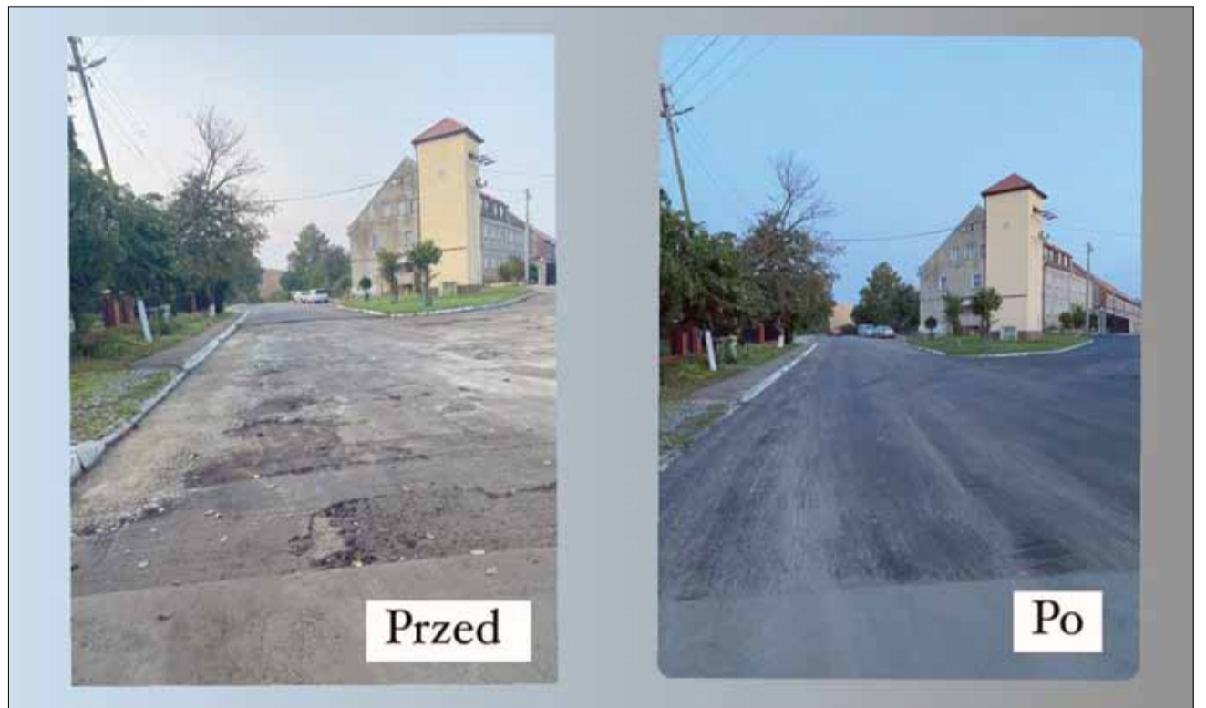
Tak zmieniła się droga w Dobrogoszczy po przeprowadzeniu remontu (fot. profil facebookowy Dobrogoszcz official)
