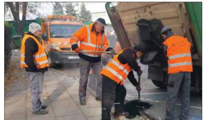
Pracownicy Centrum Usług Komunalnych i Technicznych w Strzelinie w ostatnim czasie łatali ubytki w gminnych drogach
