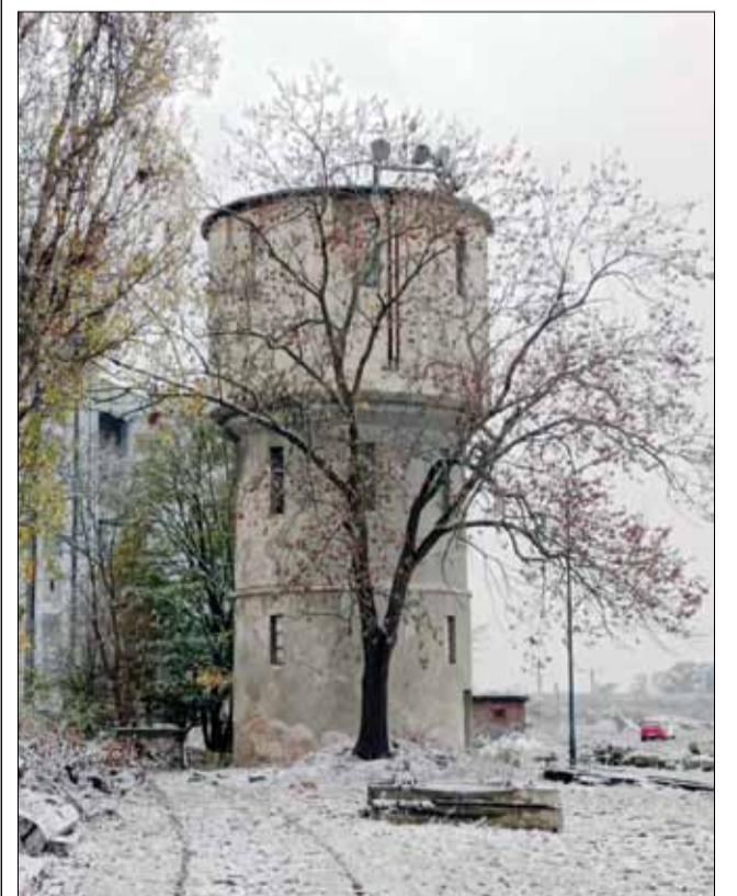
Wieża ciśnień znajduje się przy torowisku, w pobliżu elewatorów zbożowych
