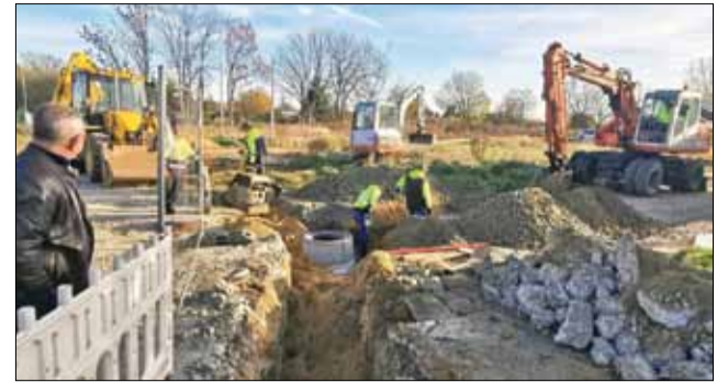
Firma prowadzi obecnie prace związane z wykonaniem kanalizacji deszczowej
