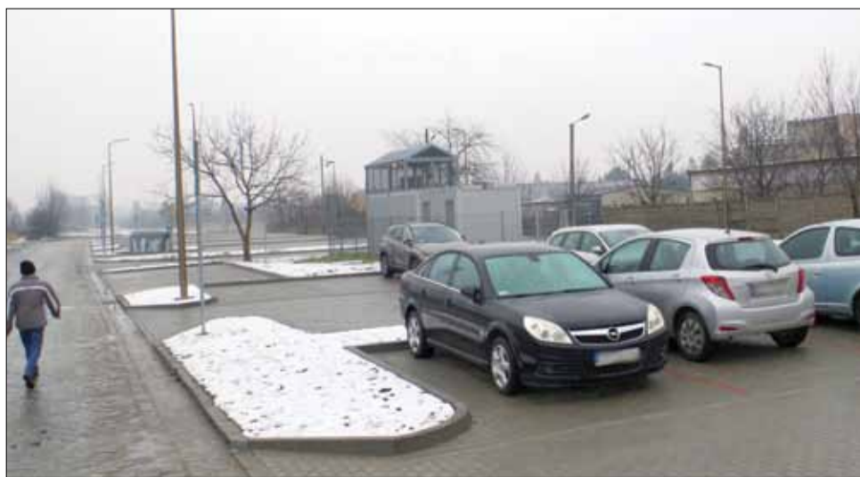
Parking, który został wykonany w ramach inwestycji jest już wykorzystywany przez kierowców
