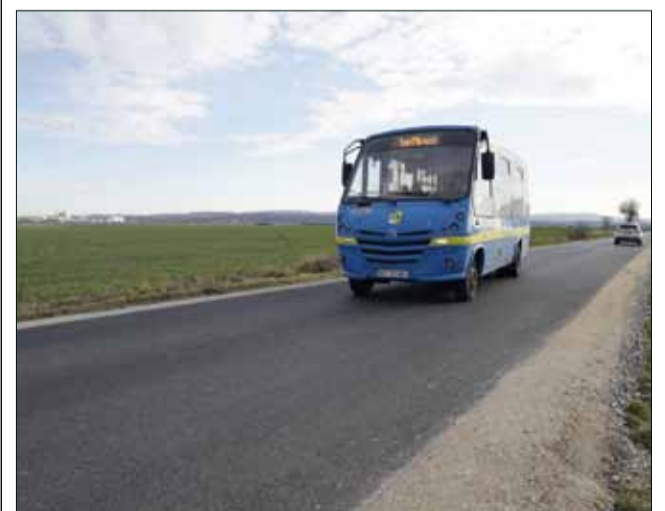
Dojazd do Dobrogoszczy możliwy jest teraz po drodze równej jak stół
