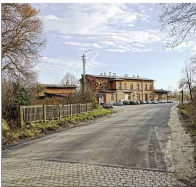
RED Nierówna kamienna droga przy dworcu w Białym Kościele została zastąpiona warstwą bitumiczną
