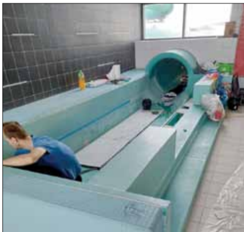
Podczas zaplanowanej przerwy technologicznej w strzełińskiej pływalni przeprowadzono szereg różnych prac, w tym m.in. renowację zjeżdżalni
