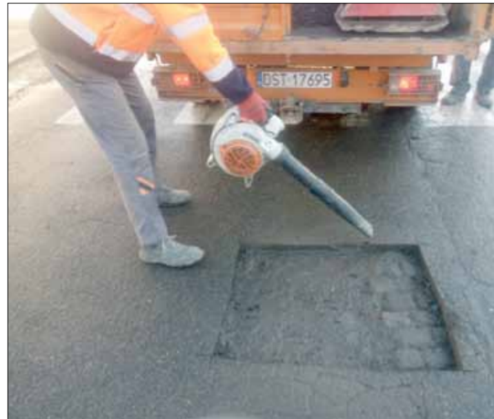
RED Ubytki zostały wypełnione masą asfaltową „na gorąco”
