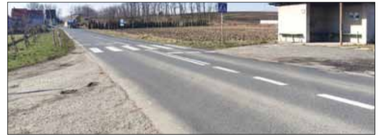
RED Inwestycja dotyczy m.in. budowy dwóch zatok autobusowych i chodnika
