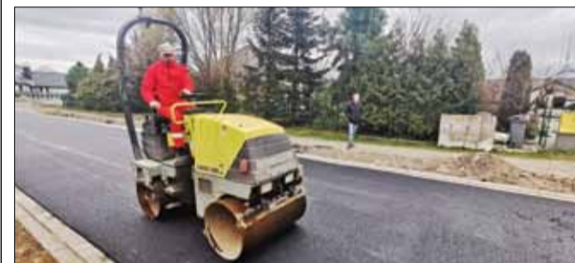
Mieszkańcy ulicy Kadłubka w Strzelinie będą mogli już poruszać się po równej drodze
