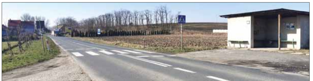
Inwestycja zakłada m.in. budowę zatok autobusowych i chodnika przy drodze wojewódzkiej
