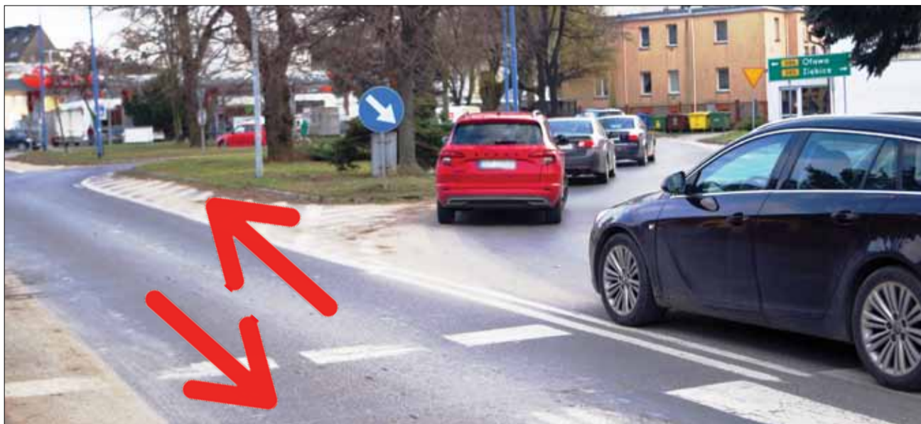
Ruch podczas przebudowy skrzyżowania przy Orlenie będzie odbywał się w obu kierunkach tak, jak wskazują czerwone strzałki
