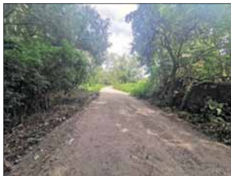
Remontowany jest odcinek drogi śródpolnej za strzeleńską cukrownią w kierunku Gęsińca
