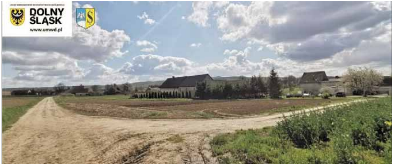
RED Remont dotyczy blisko 400-metrowego odcinka drogi śródpolnej
