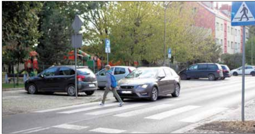
W przyszłym roku przejście dla pieszych na ul. Piłsudskiego w Strzelinie zostanie przebudowane
