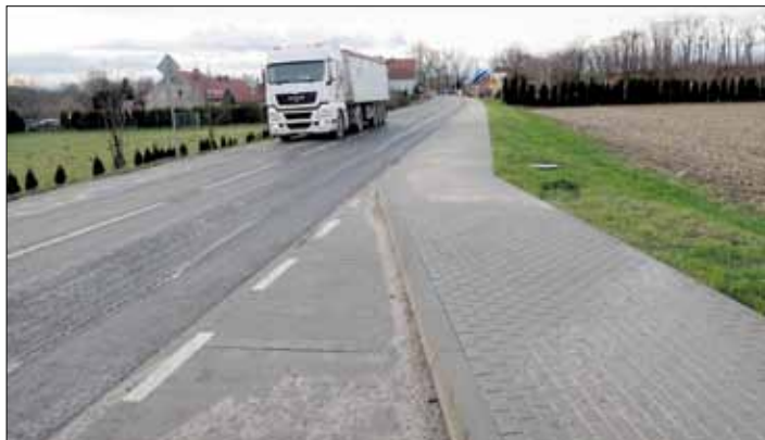
Przebiegająca przez Szczodrowice droga jest bardzo ruchliwa, dlatego budowa chodnika była kluczowa dla bezpieczeństwa mieszkańców
