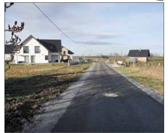
Remont dotyczył ok. 120-metrowego odcinka ulicy Diamentowej w Szczawinie
