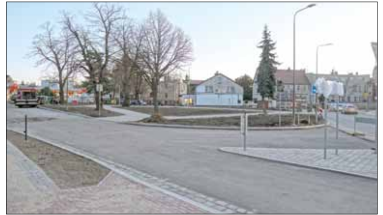
Inwestycją realizowaną przy udziale gminy jest m.in. przebudowa newralgicznego skrzyżowania ulic - Wrocławskiej, Olawskiej i Wolności w Strzelinie
