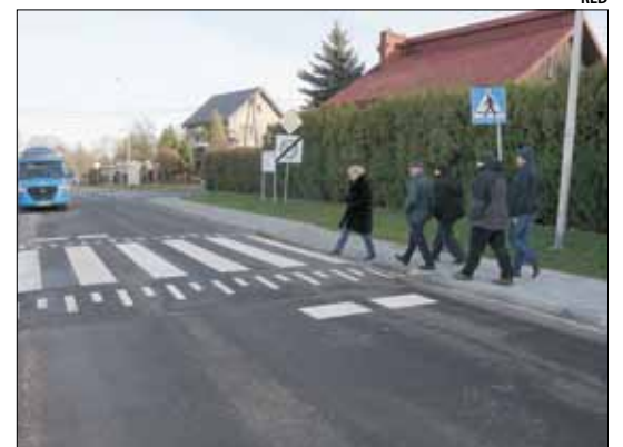
W ramach inwestycji oprócz remontu drogi wykonano również wyniesione przejście dla pieszych
