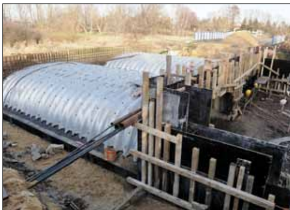
Gołym okiem widać jak duży jest zakres robót przy przebudowie mostu
