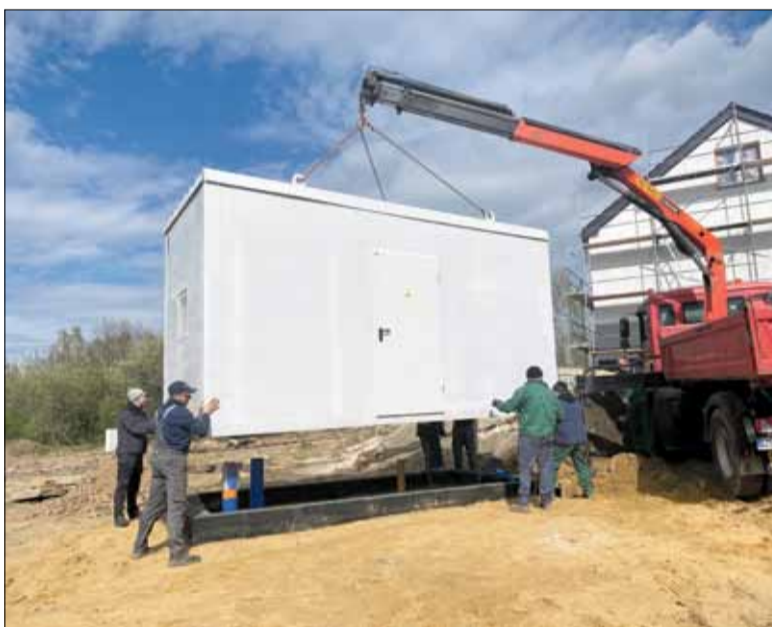
Kontener przepompowni został już umieszczony na działce przy ul. Wichrowej w Strzelinie
