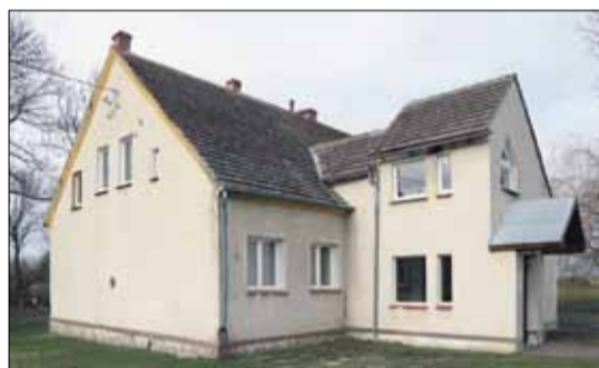
Świetlica w Piotrowicach wreszcie zyska nowy dach
