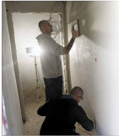
Inwestycję realizuje firma ALFI-BAU
