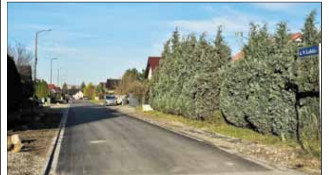
Remont wykonała lokalna firma z Pęcza
