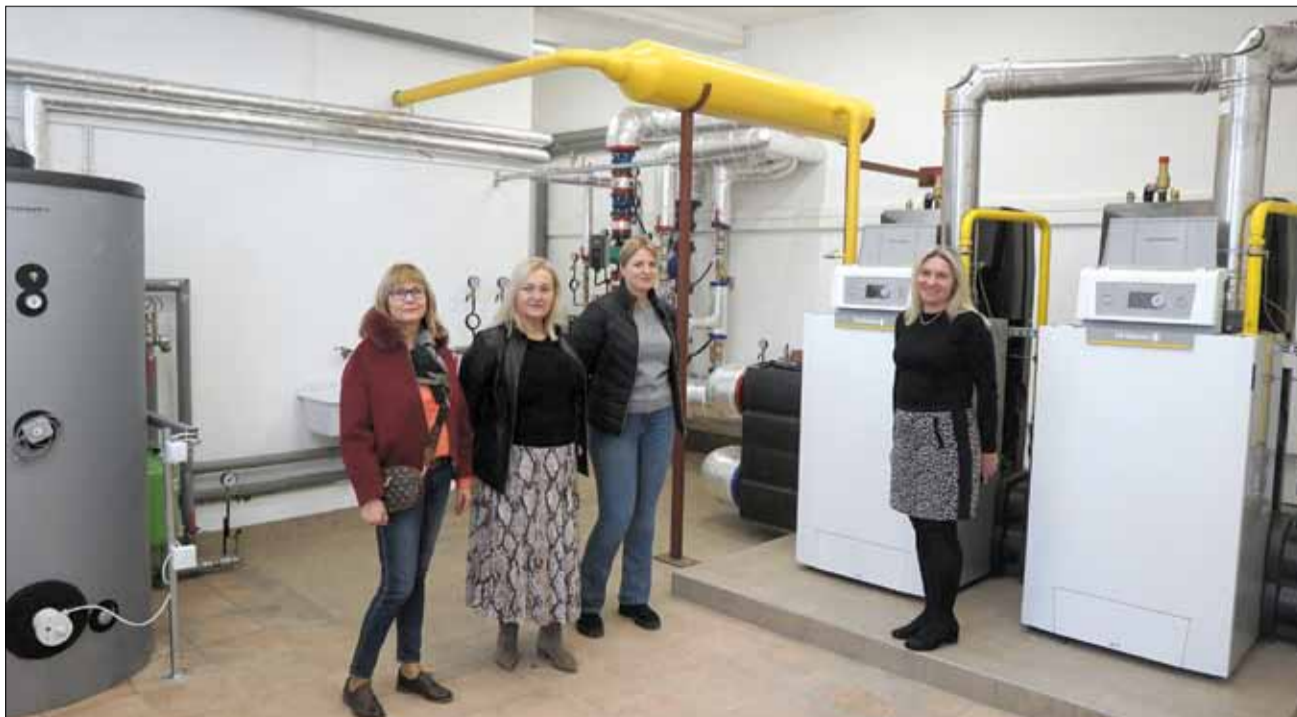
Remont kotłowni w szkole niewątpliwie poprawi efektywność energetyczną budynku
