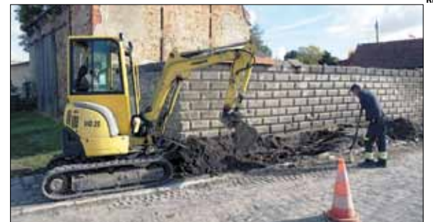
Starą betonową nawierzchnię chodnika zastąpiła nowa z kostki brukowej
